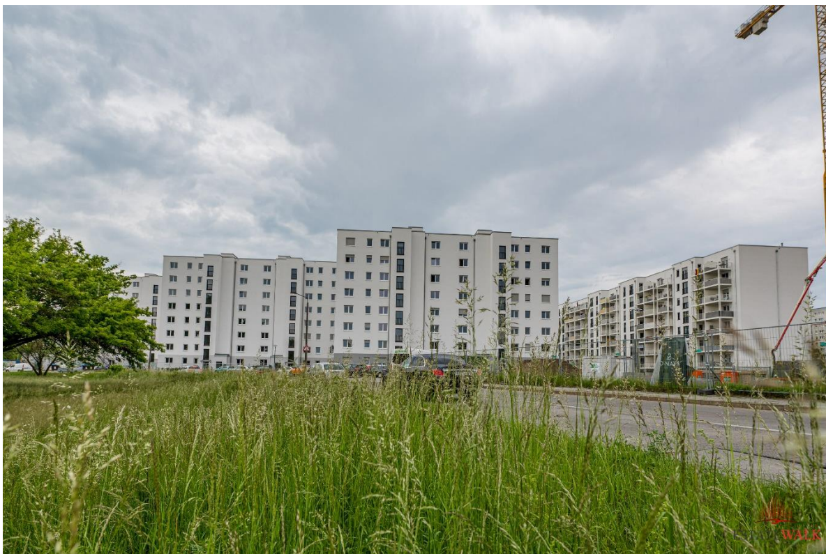
Blick auf die fertigen Mietwohnungen an der Märkischen Allee Ecke Wuhletaler Fenster. Vorn rechts im Bild: Die Baustelle für das Wohnhochhaus Wuhletaler Fenster. Fotograf: Roger Rachel / Estatewalk
